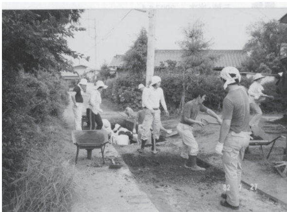
①南側 (テニスコート側) の掘削開始
